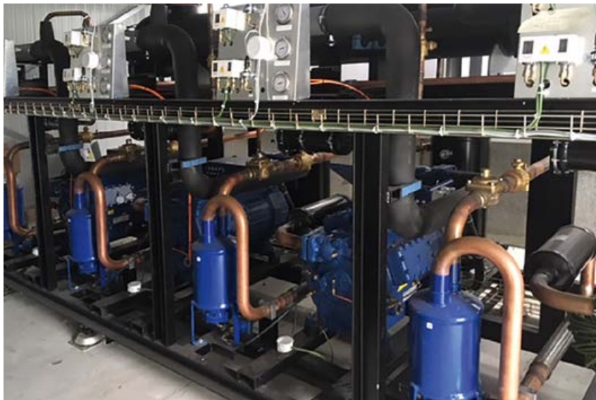
Une installation frigorifique industrielle sur un solide châssis, facile à entretenir par l'installateur et prête pour des extensions futures.
