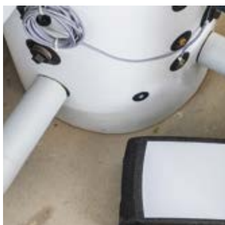
Récupération de chaleur
